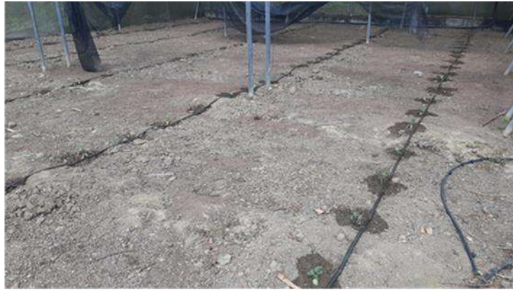
figura 9: Sistema de riego instalado y funcional
