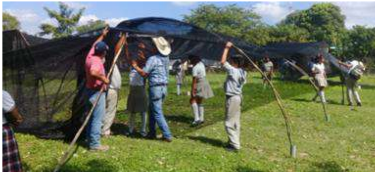
Figura 5. Estructura de Macrotúnel construido con Jimba (Olmecca erecta).
